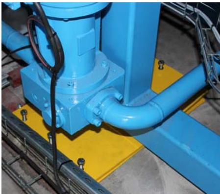
On retrouve l'effet amortisseur de vibration qui évite la transmission de vibration de la Machine/Sol et du Sol/Machine.
