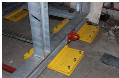
Le clameur ne nécessite aucune soudure pour son montage.
